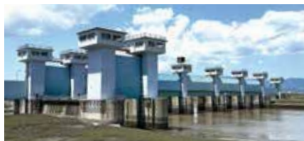
◀六角川の六角川河口堰。大雨時は堰を開け閉めして、潮位上昇による高潮対策として運用されています。
