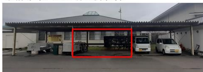
駐輪場（ゆうあい館北側車庫）
