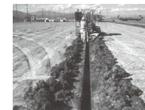
②暗渠排水整備
