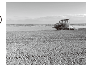
①区画拡大整備
