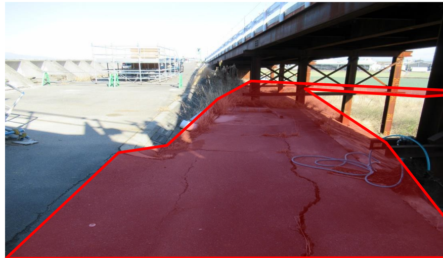
⑩ 2号道路【新設】
