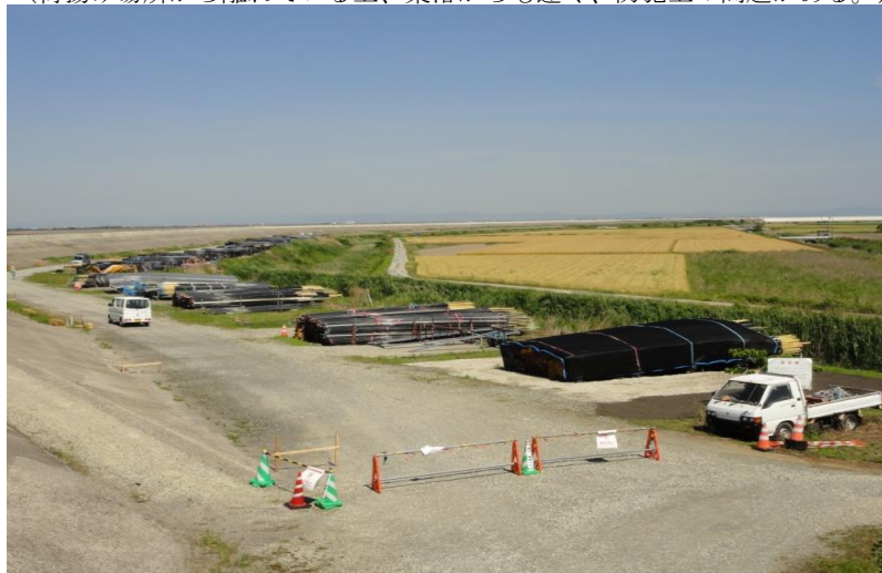
⑳海苔養殖用支柱保管場所写真【海岸堤防敷地内】 （荷揚げ場所から離れている上、集落からも遠く、防犯上の問題がある。）
