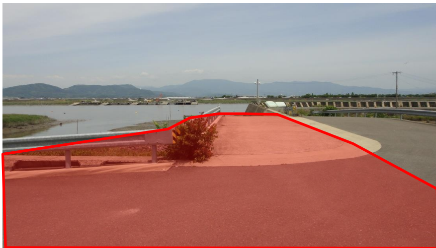
⑨ 1号道路【新設】
