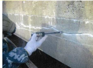
補修状況（側面）
