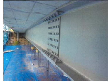
補修後（鋼主桁）
