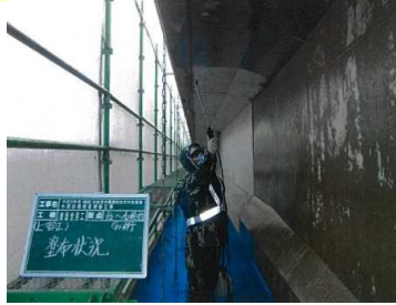
補修状況（主桁）
