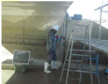
補修状況（下部工）
