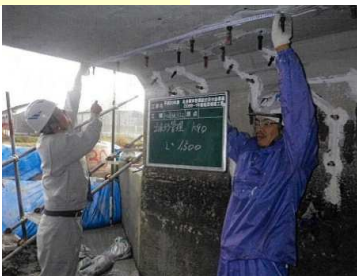
補修状況（主桁と下部工）
