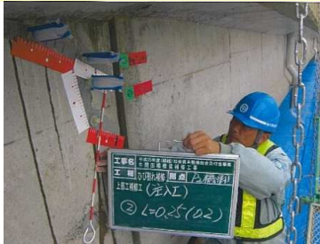
補修状況（主桁）
