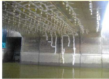
補修状況（桁下と下部工）
