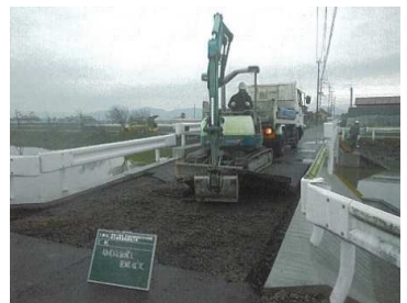
補修状況（橋面）
