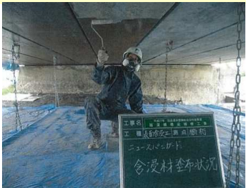
補修状況（主桁）
