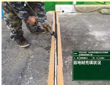
補修状況（伸縮継手部）
