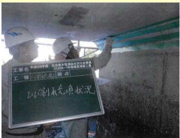
補修状況（主桁と下部工）
