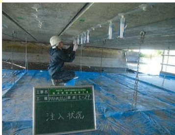
補修状況（主桁）
