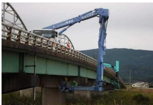
橋梁点検車による定期点検
