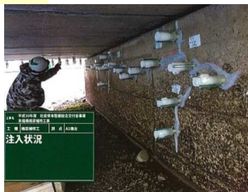
補修状況（桁下と下部工）
