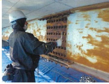
補修状況（鋼主桁）
