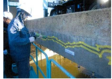
補修状況（側面）
