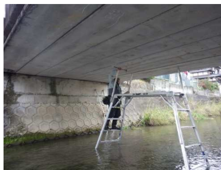
定期点検（打音検査）状況
