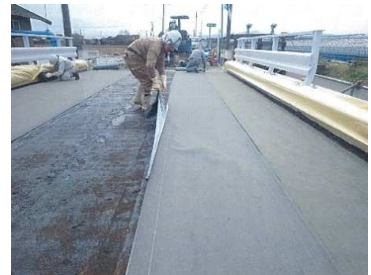
補修状況（橋面）
