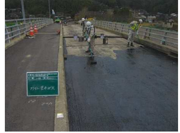
補修状況（橋面）
