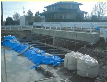
補修状況（仮締切）
