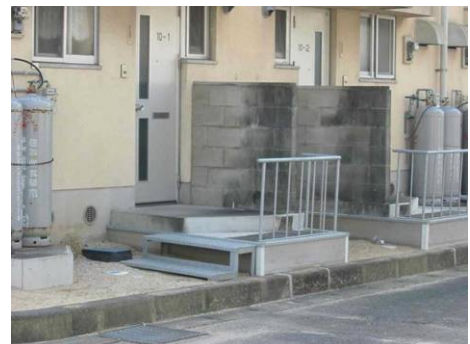
町営住ノ江住宅の地盤沈下対策
