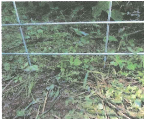
WM柵は地面に刺さるくらい踏み込んでから固定する。
