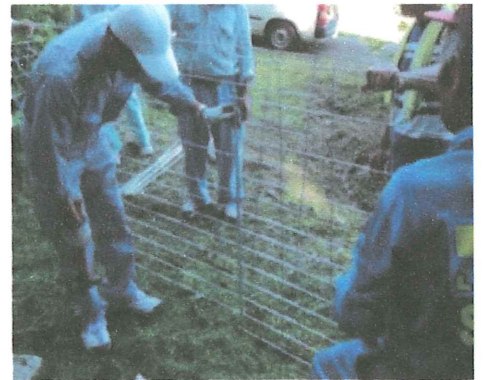
支柱の上端がWMの上端より下になるくらいまで、しっかり支柱を打ち込む。
