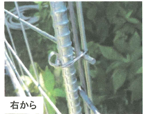
支柱の上端がWMの上端より下になるくらいまで、しっかり支柱を打ち込む。
