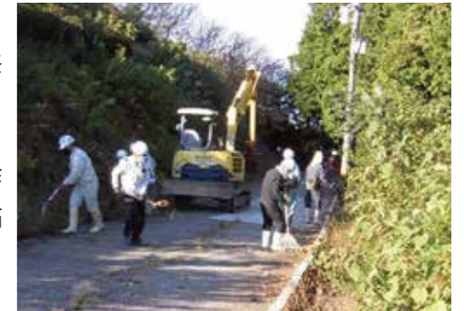
▲作業後の道路はスッキリきれいに!
