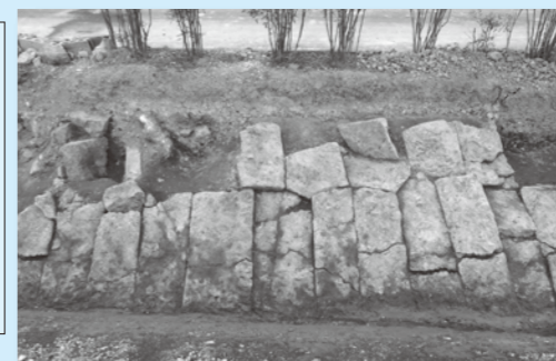
赤石護岸(東から)
