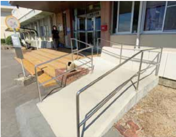
●階段の横に造られたスロープ
