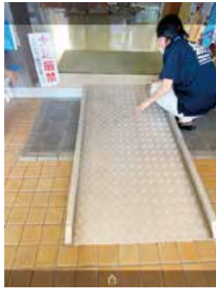
●ホールへの段差をなくすために必要に応じて仮設するスロープ
