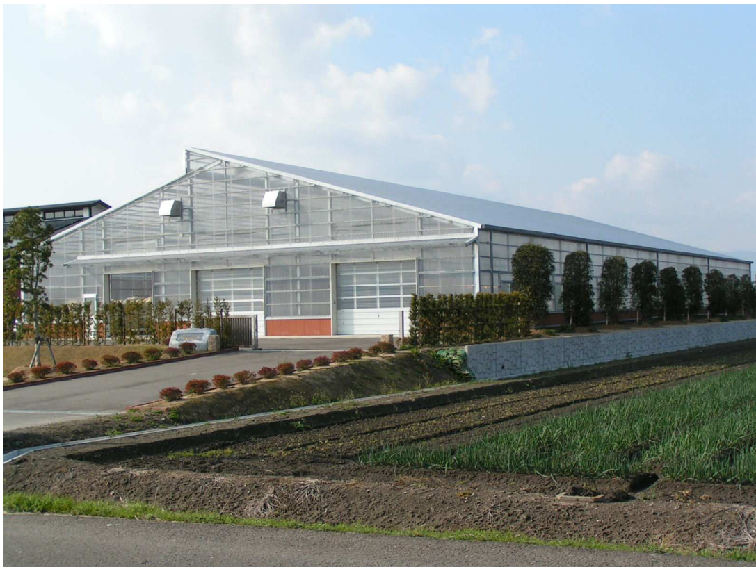
住ノ江地区資源循環施設
