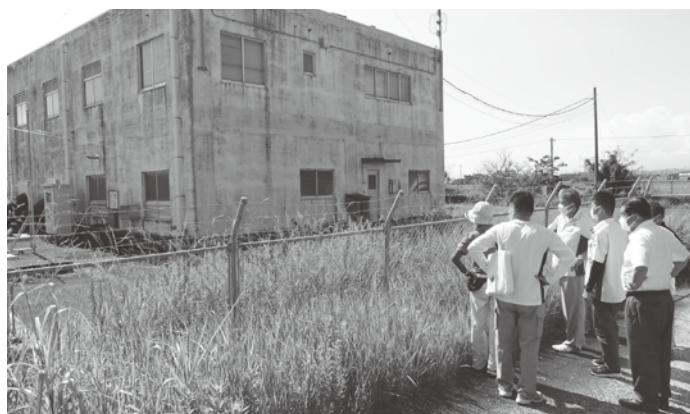
●産業建設常任委員会による須古川排水機場現地調査
