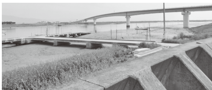
●六角川下流部 (六角川大橋付近)
