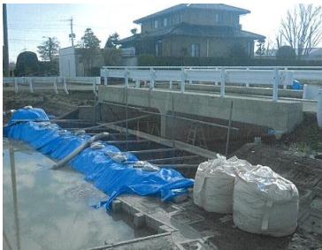
補修状況（仮締切）
