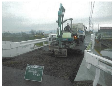
補修状況（橋面）
