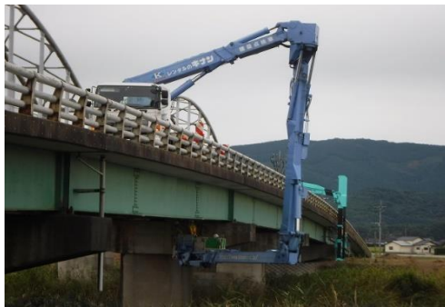
橋梁点検車による定期点検
