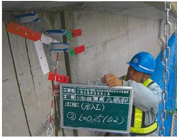
補修状況（主桁）
