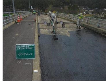
補修状況（橋面）
