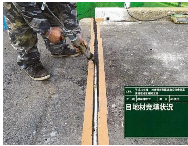
補修状況（伸縮継手部）
