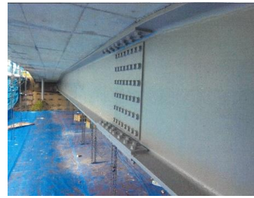
補修後（鋼主桁）
