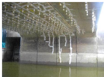
補修状況（桁下と下部工）
