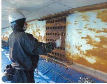
補修状況（鋼主桁）
