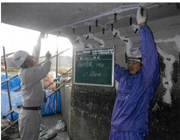
補修状況（主桁と下部工）
