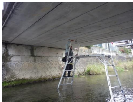
定期点検（打音検査）状況
