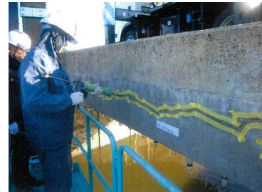
補修状況（側面）
