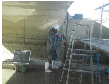
補修状況（下部工）
