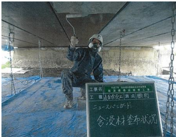
補修状況（主桁）
