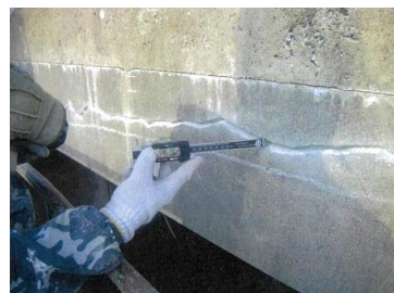
補修状況（側面）
