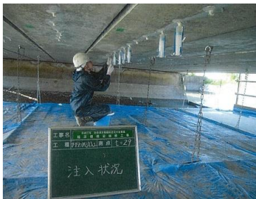
補修状況（主桁）
