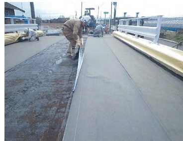
補修状況（橋面）
