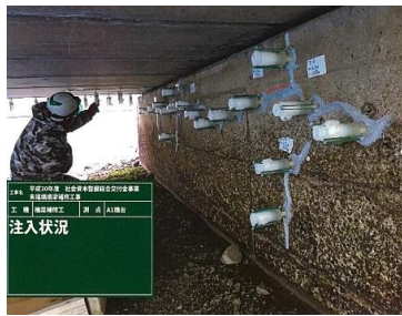
補修状況（桁下と下部工）
