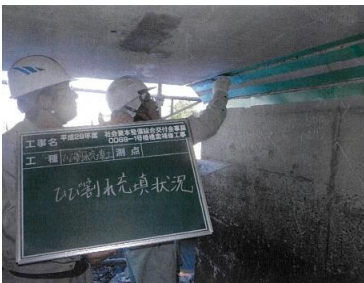
補修状況（主桁と下部工）
