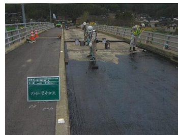
補修状況（橋面）
