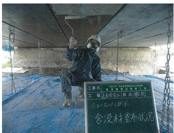
補修状況（主桁）
