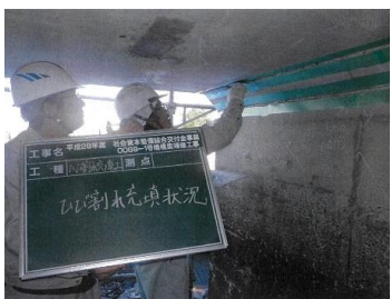
補修状況（主桁と下部工）
