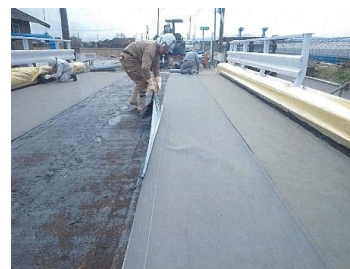
補修状況（橋面）
