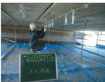
補修状況（主桁）
