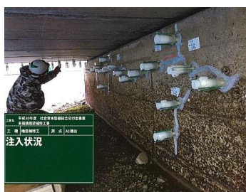
補修状況（桁下と下部工）
