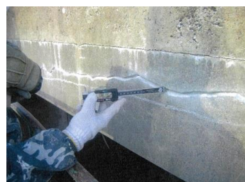
補修状況（側面）
