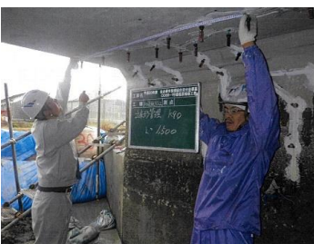
補修状況（主桁と下部工）
