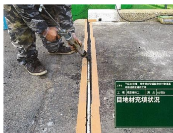
補修状況（伸縮継手部）
