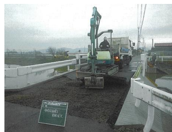
補修状況（橋面）
