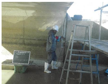
補修状況（下部工）
