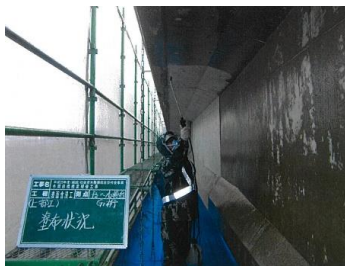
補修状況（主桁）
