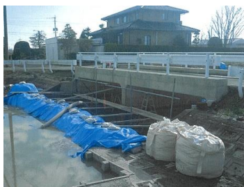
補修状況（仮締切）
