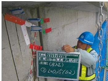
補修状況（主桁）
