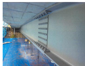
補修後（鋼主桁）
