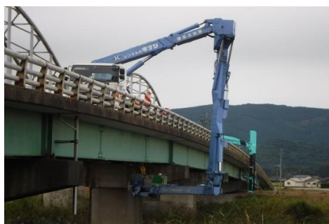
橋梁点検車による定期点検
