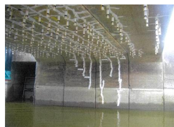
補修状況（桁下と下部工）
