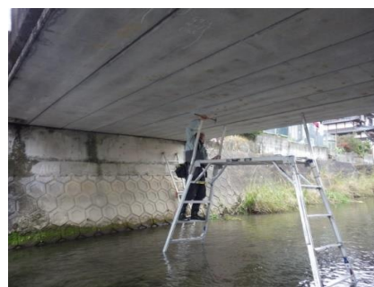
定期点検（打音検査）状況
