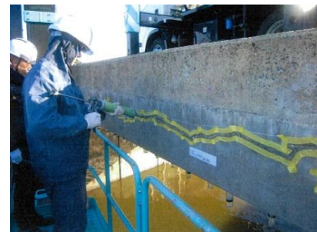
補修状況（側面）
