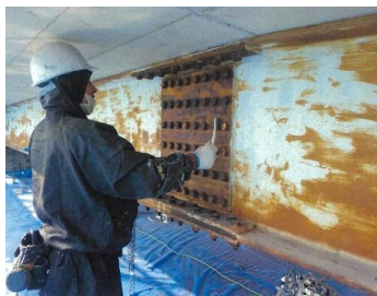
補修状況（鋼主桁）
