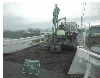
補修状況 (橋面)
