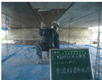
補修状況 (主桁)
