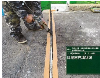
補修状況（伸縮継手部）
