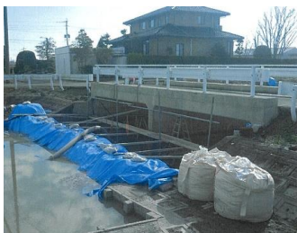
補修状況 (仮締切)
