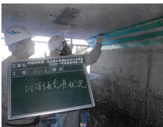
補修状況 (主桁と下部工)
