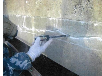
補修状況（側面）
