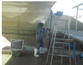
補修状況 (下部工)
