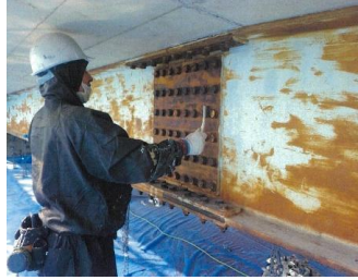
補修状況（鋼主桁）
