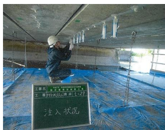
補修状況 (主桁)
