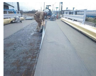
補修状況 (橋面)
