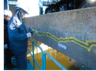
補修状況（側面）
