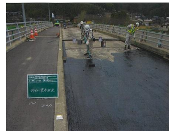
補修状況 (橋面)
