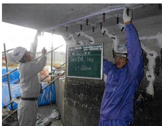
補修状況 (主桁と下部工)
