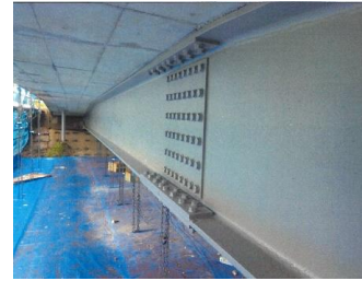
補修後（鋼主桁）
