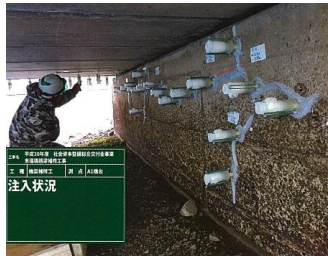
補修状況（桁下と下部工）
