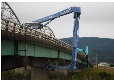
橋梁点検車による定期点検
