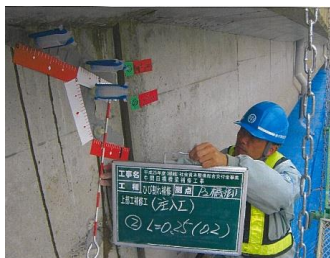
補修状況 (主桁)
