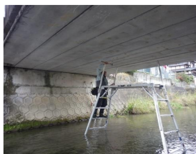
定期点検（打音検査）状況
