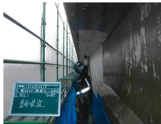
補修状況 (主桁)
