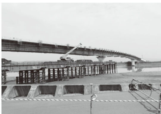
●建設中の六角川大橋
