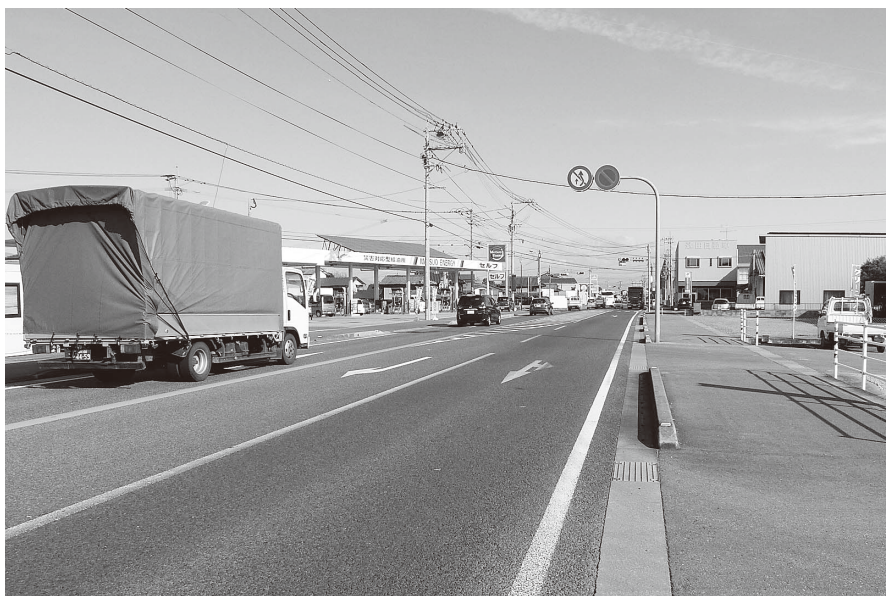
●大型車両の通行が多い町内の国道
