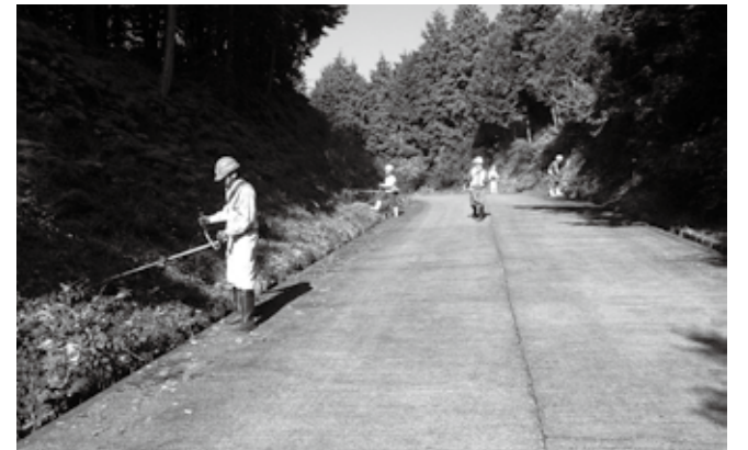
■杵島建設業協会による除草作業
