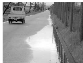
町道の冠水状況
