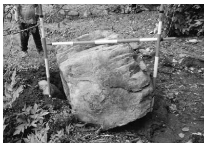
◆急傾斜危険区域(落石の様子)
