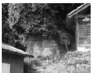
◆危険箇所（川津地区）
