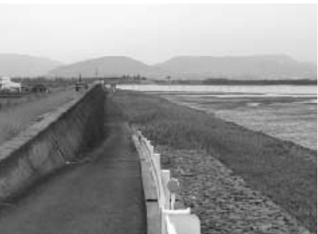
◆町内の第1線堤防
