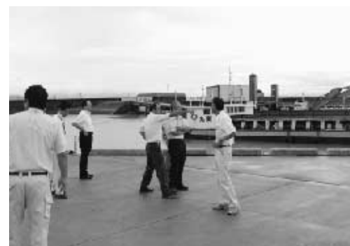
◆工事の進捗状況を調査
