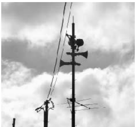
◆防災無線の屋外スピーカー
