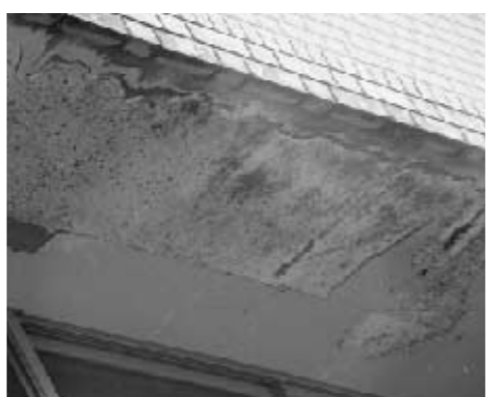
◆老朽化した学校施設の外壁
