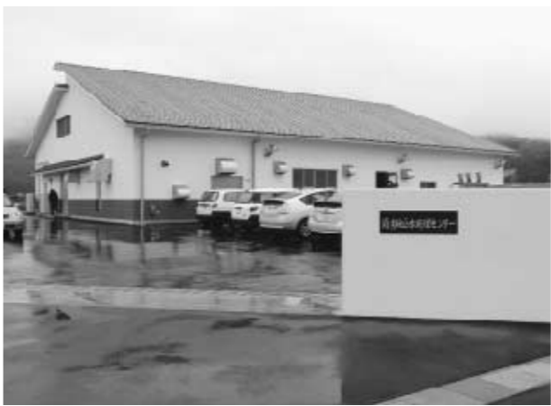
◆須古地区農業集落排水処理施設
