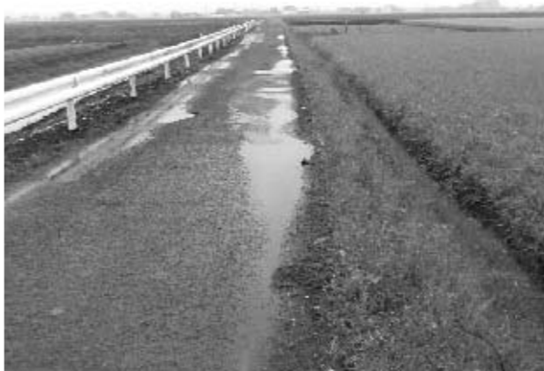
◆町内の農道（狭く痛み、田面と高低差がある）
