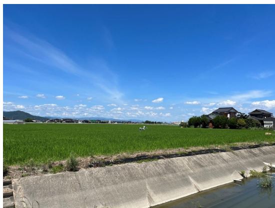
1. 南東側水路境界部
