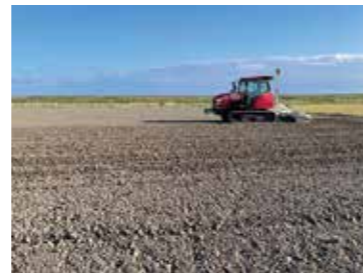
①区画拡大整備
